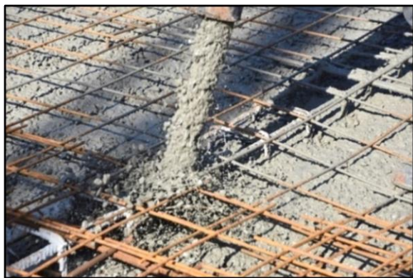
Рисунок I-1. Бетонування монолітних конструкцій ГТС
