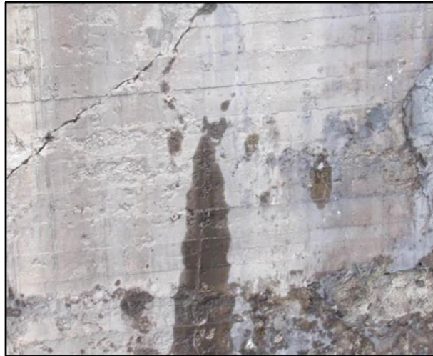
Рисунки 5.1 і 5.2 - Фільтрація води крізь бетон биків бетонної водозливної греблі
