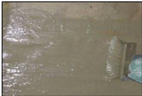
Рисунок II-2-1. Нанесення розчинової суміші Penetron на бетонну поверхню
