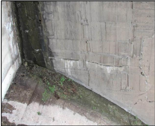
Рисунки 5.1 і 5.2 - Фільтрація води крізь бетон биків бетонної водозливної греблі
