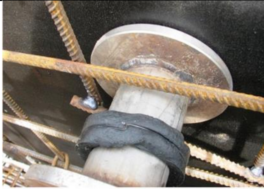
Рисунок I-3-1. Монтаж комунікаційної труби з гільзою типу «бетон-гільза»
