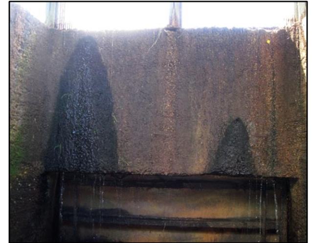
Рисунок 5.3 - Фільтрація води крізь забральну стінку регуляційної споруди
