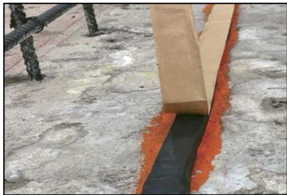
Рисунок I-2. Монтаж бентонітового джгута Penebar вздовж шва бетонування
