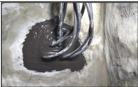
Рисунок П-1-2. Улаштування гідроізоляції місць вводу комунікацій
