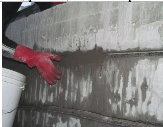
Рисунок I-5-1. Улаштування гідроізоляції стиків збірних елементів
