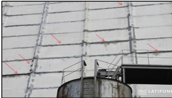
Рисунок П-7-1. Місця зволоження збірних елементів силосу крізь нещільні стики
