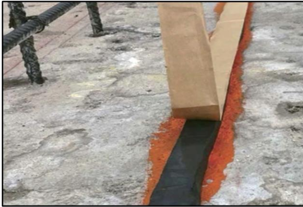
Рисунок I-2-1. Монтаж бентонітового джгута Penebar вздовж шва бетонування
