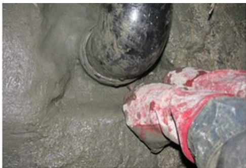
Рисунок П-4-2. Улаштування гідроізоляції місць вводу комунікацій
