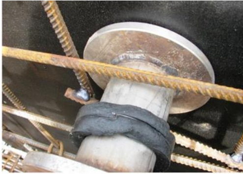
Рисунок I-6-1. Монтаж комунікаційної труби з гільзою типу «бетон-гільза»
