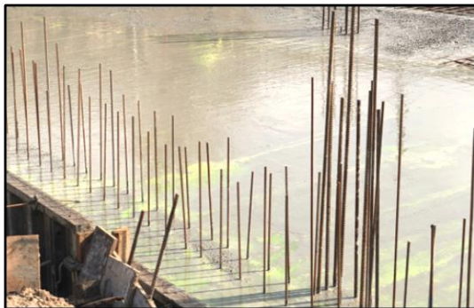
Рисунок I-3-3. Застосування добавки Penetron Admix для монолітного бетону
