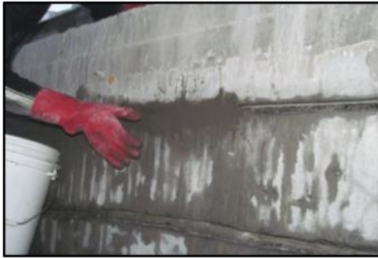
Рисунок II-2-1. Підготовка штроб для гідроізоляції збірних блоків
