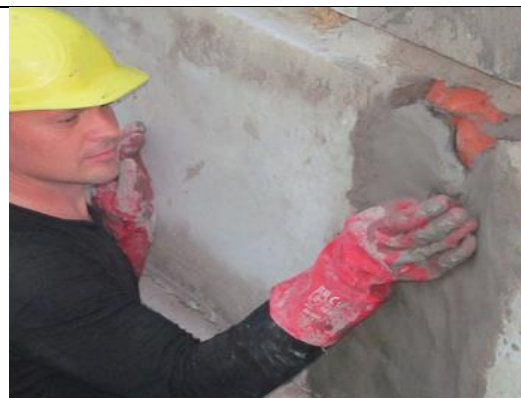
Рисунок I-5-2. Улаштування гідроізоляції примикань збірних елементів
