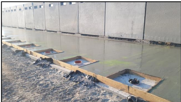
Рисунок I-1-1. Бетонування монолітних конструкцій споруд для тваринництва
