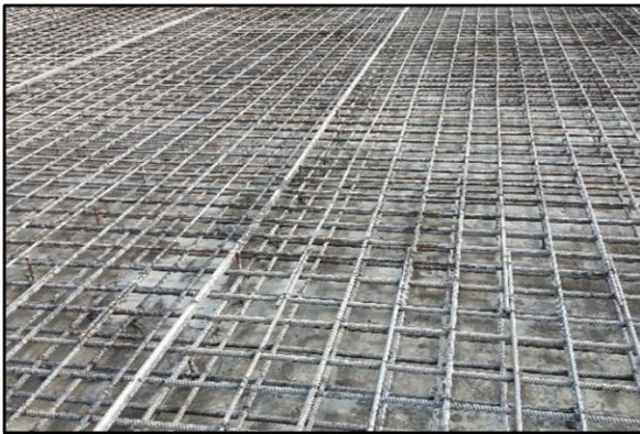
Рисунок П-1-2. Контактний (адгезійний) шар для антикорозійного захисту арматурних сіток та підвищення адгезії до бетону і арматури
