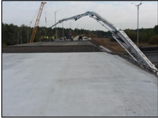
Рисунок I-1-1. Бетонування плити проїзної частини
