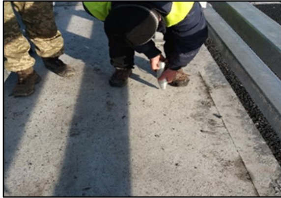
Рисунок II-2-1. Монолітні тротуари зі щільного водонепроникного бетону
