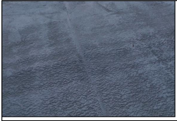
Рисунок П-1-1. Бетонування плити проїзної частини
