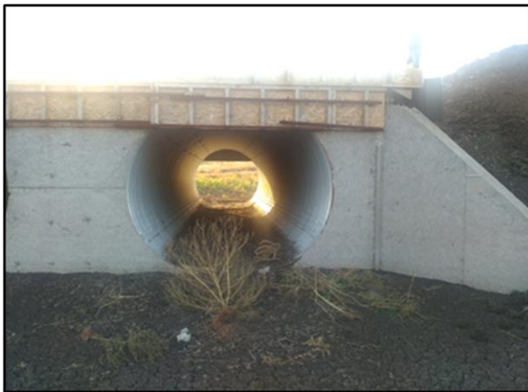
Рисунок IV-1-2. Влаштування бетонного порталу труби дорожньої
