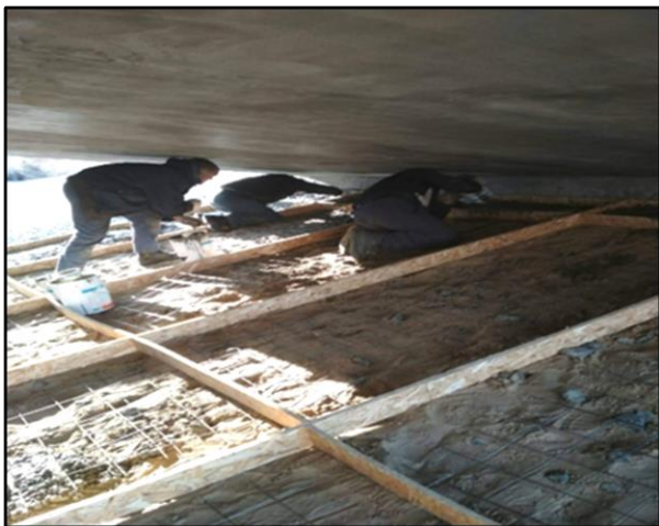
Рисунок I-5-1. Улаштування бетонного укріплення конуса насипу
