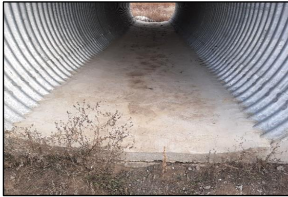
Рисунок IV-1-1. Влаштування бетонного лотка всередині труби
