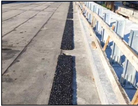
Рисунок I-3-1. Влаштування капілярного дренажу проїзної частини вздовж бордюру
