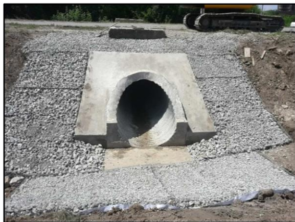
Рисунок IV-2-1. Улаштування вхідного/вихідного лотка та оголовка труби дорожньої
