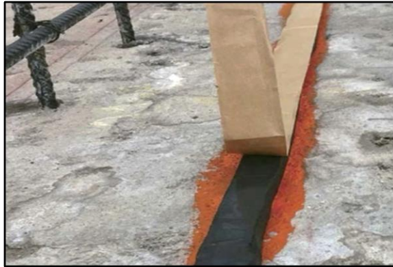
Рисунок I-2. Монтаж бентонітового джгута Penebar вздовж шва бетонування
