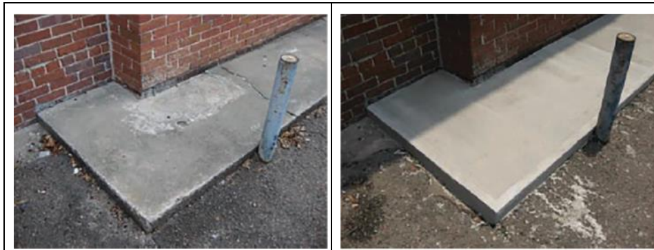
а) б) Рисунок 1 – Бетон, відновлений Renew CR: а) до нанесення; б) після нанесення
