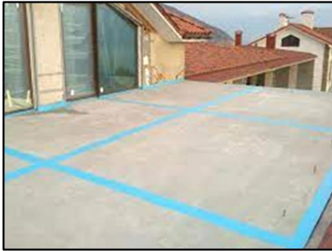
Рисунок П-12-1. Підготовка існуючої бетонної основи під нанесення гідроізоляційного матеріалу проникаючої дії
