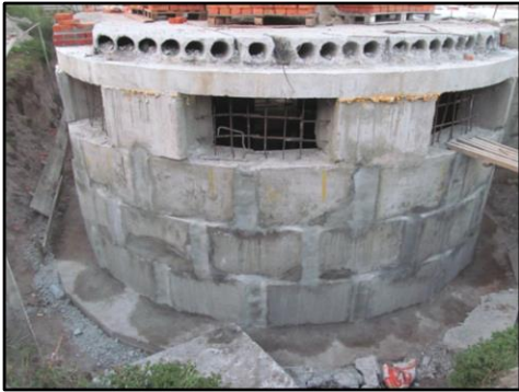
Рисунок I-9-1. Улаштування гідроізоляції стиків збірних елементів
