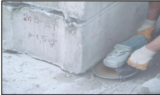
Рисунок II-2-1. Підготовка штроб для гідроізоляції збірних конструкцій
