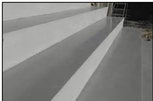
Рисунок П-11-1. Відновлення покриття бетонних сходів вхідної групи
